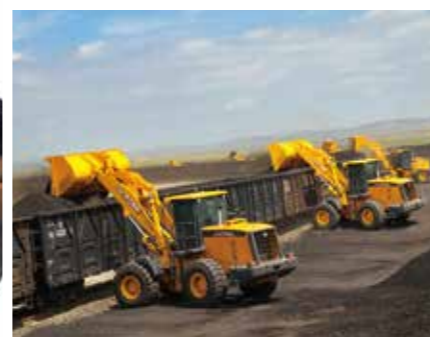
Группа погрузчиков LW500K XCMG проводят строительство
