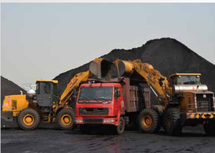
Погрузчики LW500K-LNG XCMG проводят строительство на порту
